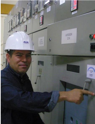
Modernización carro de media tensión en tren de celdas
