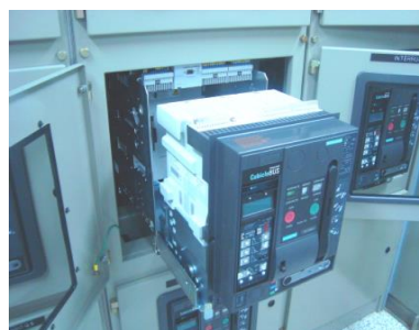
Modernización tableros de baja tensión de alta corriente
